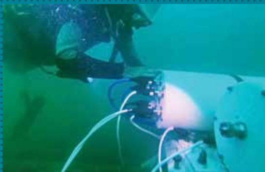
Пуско-наладочные работы на газопроводе «Джубга-Лазаревское-Сочи»
