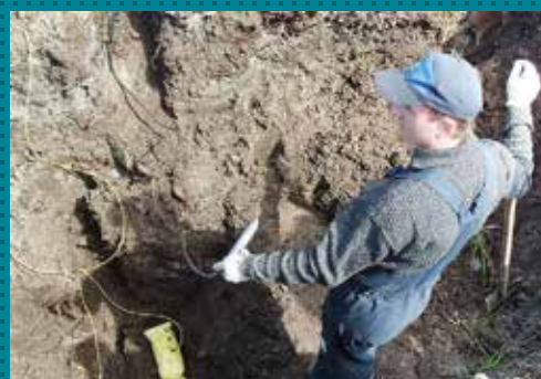
Монтаж ПКМ-ТСТ-КонтКорр®
