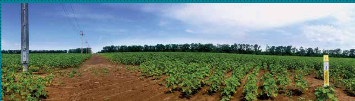
ПКМ-ТСТ-УЗТ на участке Березанского ЛПУМГ
